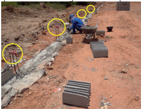
Figura 6 – Utilização de protetores de vergalhões de aço nos pilares do muro
