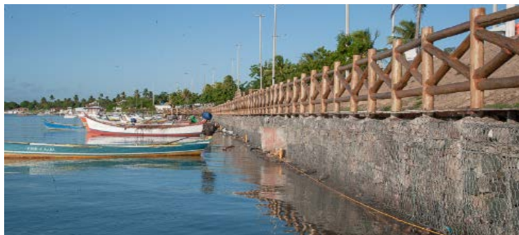
Figura 12 – Muro de gabião finalizado na Orla Pôr-do-Sol em Aracaju
