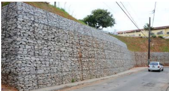
Figura 13 – Muro de gabião na Vila Sabiá
