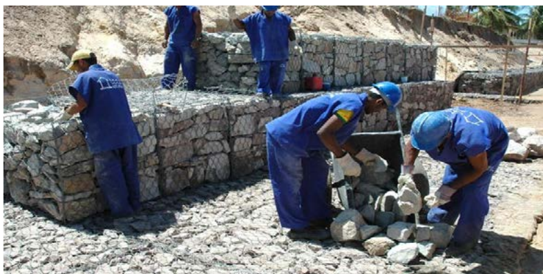
Figura 11 – Muro de gabião em execução na Orla Pôr-do-Sol em Aracaju
