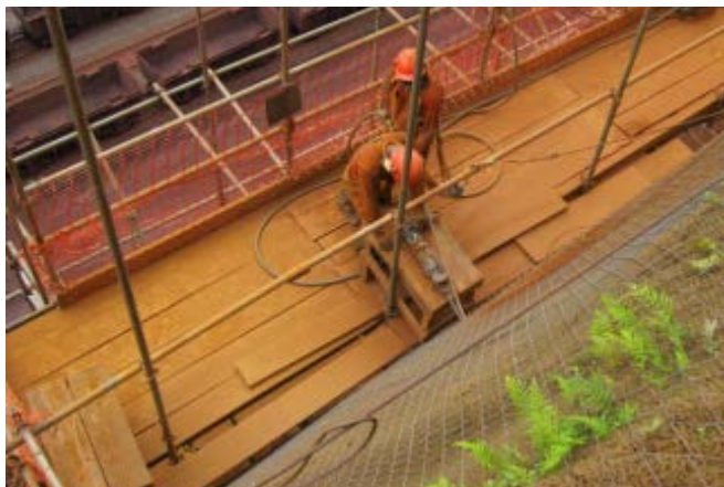
Figura 11 – Ancoragem dos grampos
