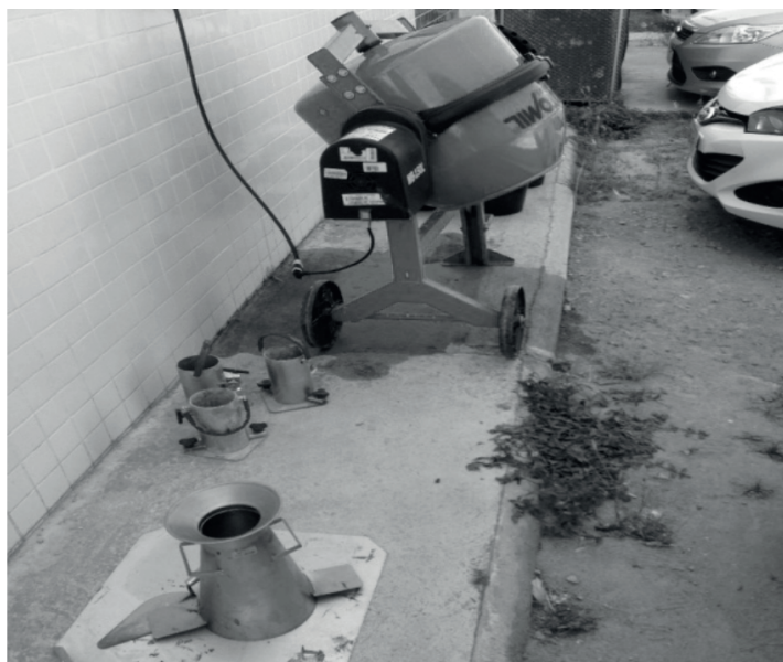
Imagem 1 - Betoneira para lavagem
