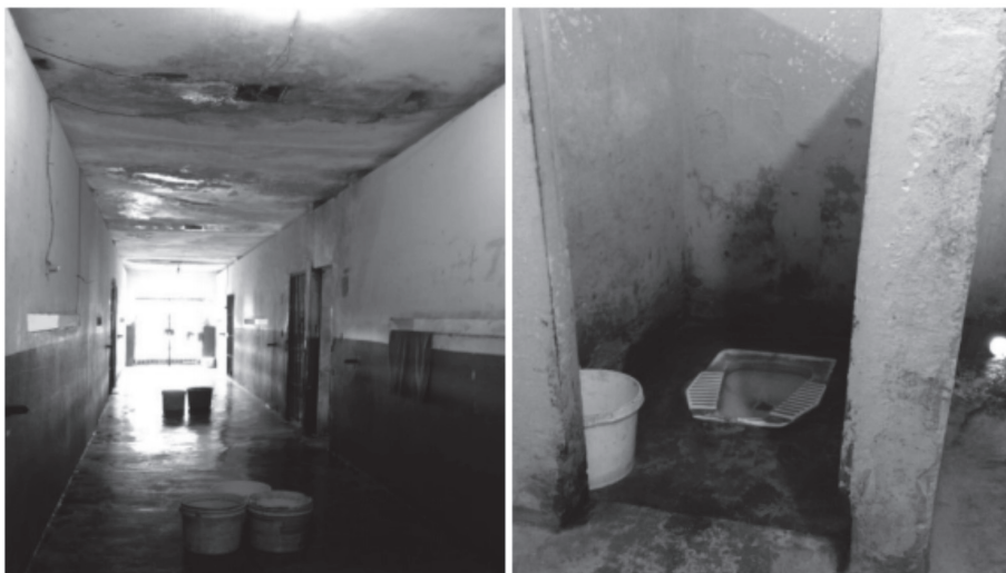
Corredor de pavilhão
